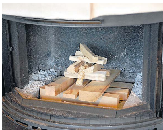
Beispielhaft: So sieht der ideale Holzaufbau in einem Cheminée aus
